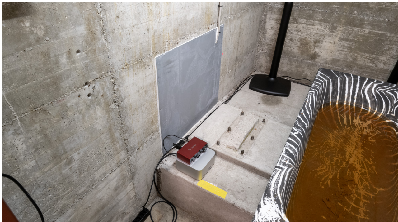
Dispositif de diffusion et baignoire, Local de l'ascenseur, sous-sol de Movimax, Sierre, Janvier 2024
